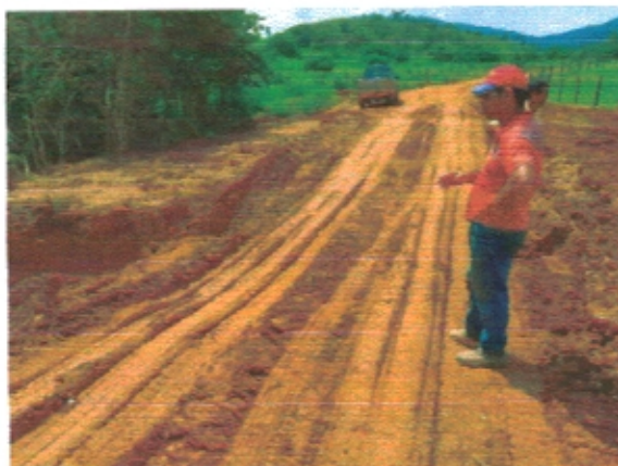
REATERRO NO LOCAL DA ANTIGA PONTE
