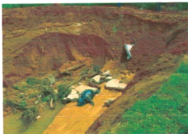
REATERRO NO LOCAL DA ANTIGA PONTE
